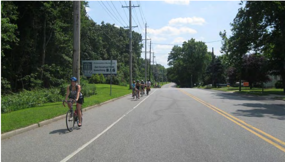
Ilustración 100. Ejemplificación de la adición de franja ciclista en carreteras suburbanas
